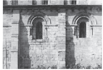
Lavilletterte nave window
