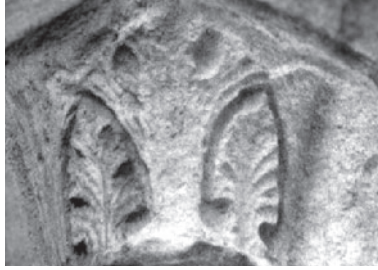
Lavilletterte nave window
